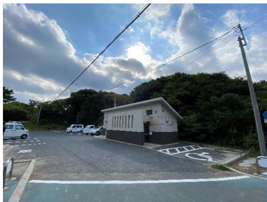
駐車場とトイレ
