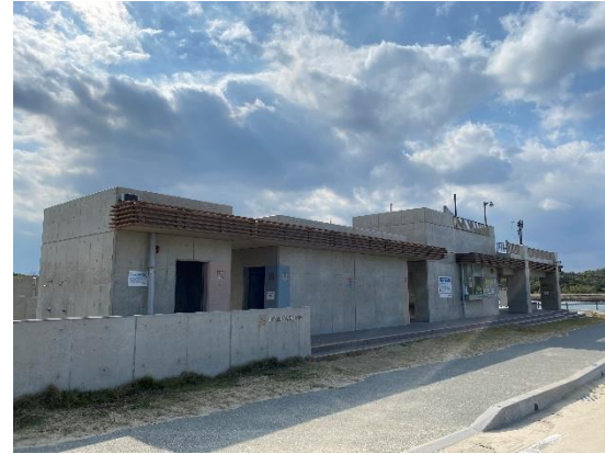
トイレ・シャワー棟
